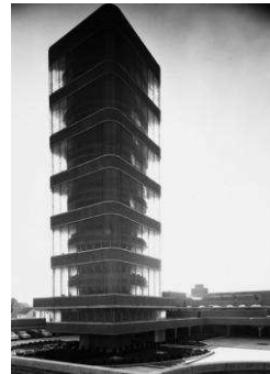
Un effetto traslucido è prodotto anche dal rivestimento in tubi di vetro pyrex della torre dei laboratori (1950): 15 piani sostenuti da una struttura in cemento armato, dal cui tronco centrale si ramificano i solai a sbalzo, di forma alternatamente quadrata con spigoli smussati e rotonda.
