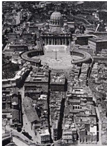
Veduta dei Borghi prima della demolizione della Spina
