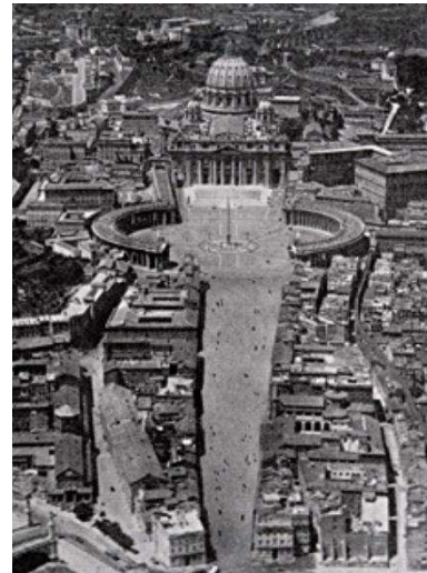
Veduta dei Borghi dopo demolizione della Spina. (Via della Conciliazione)
