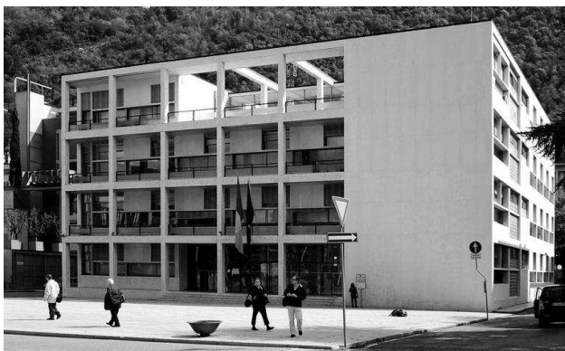
Prospetto sulla piazza
